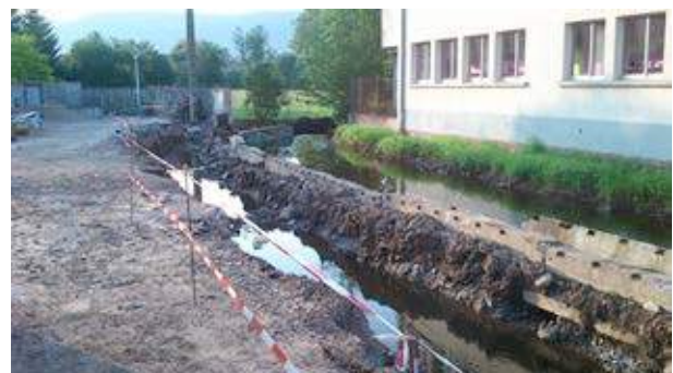
Dépose du mur de soutènement et mise en place du batardeau
