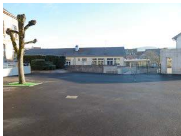
la cour de l'école terminée
