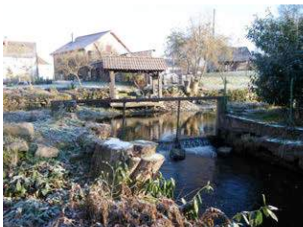
Barrage du ruisseau de La Mer
