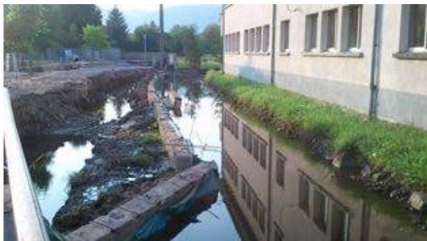
Dépose du mur de soutènement et mise en place du batardeau
