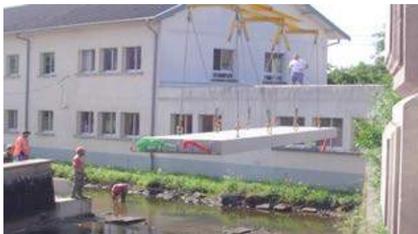
mise en place de la passerelle
