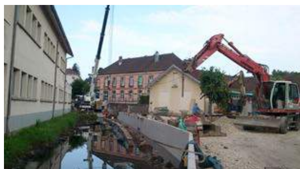
Construction du mur de soutènement
